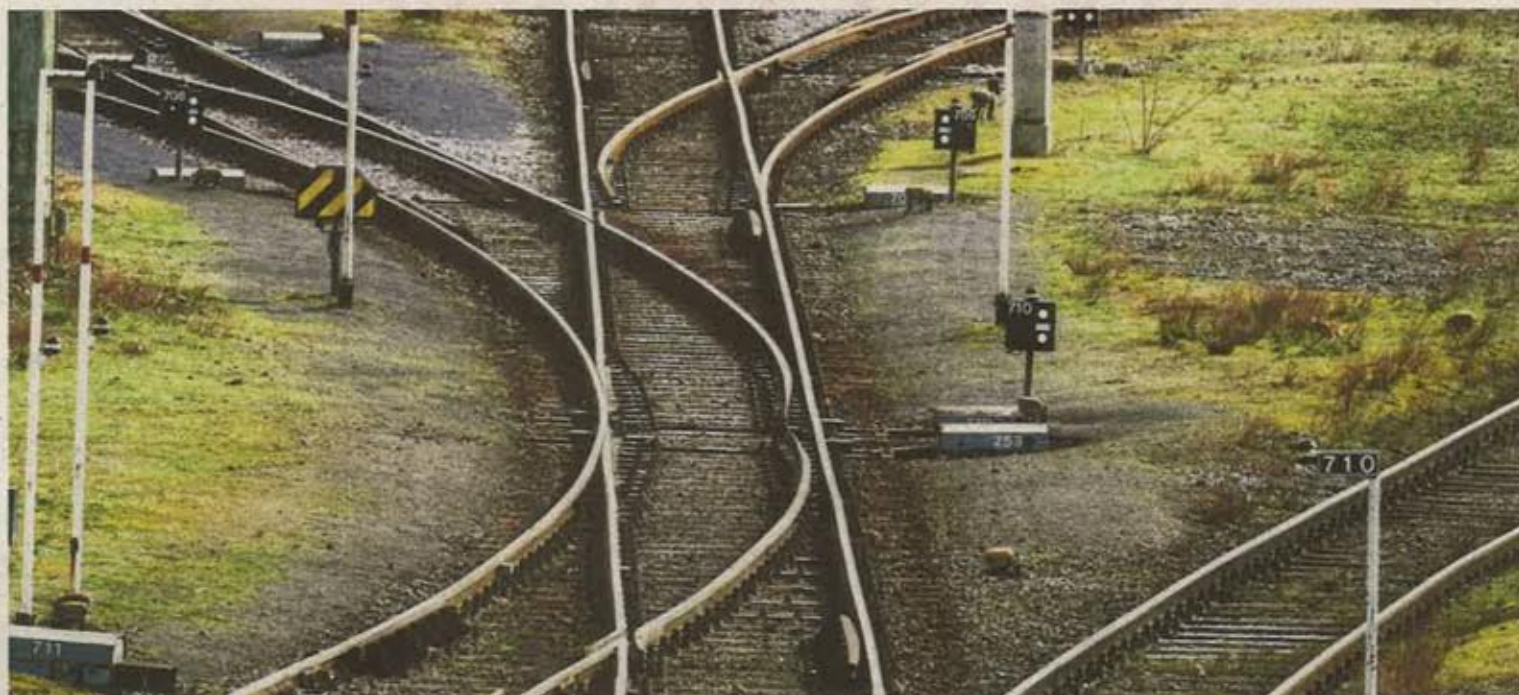
Am Gewerbegebiet Heißen-Ost besteht noch eine Schienenanbindung, doch ansässige Unternehmen können diese nicht nutzen – das Anschlussgleis ist seit längerem stillgelegt.
